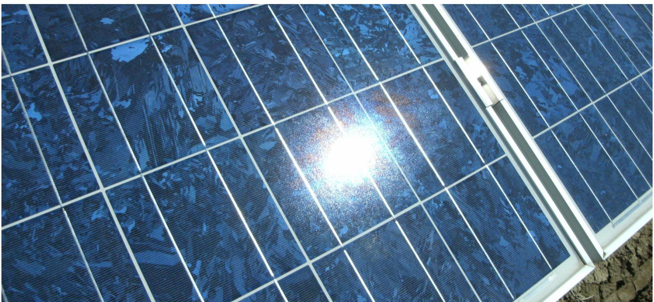
Bild S10: Diffuse Reflexion von direkten Sonnenlicht (Einstrahlung ca. 980 W/m<sup>2</sup>) auf einem PV Modul (Quelle: SolPEG)
