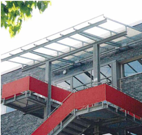
Im Bereich der Hauptzugänge und außen liegenden Fluchttreppen sollten bauliche Schutzmaßnahmen gegen Witterungseinflüsse vorgesehen werden. Einen ausreichenden Schutz bieten z. B. entsprechend bemessene Vordächer. Sofern diese verglast ausgeführt werden, sind die Anforderungen an Überkopfverglasungen zu beachten.
