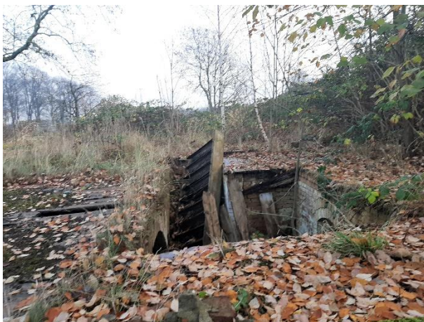
Ruine mit Keller im Südwesten des Plangebietes
