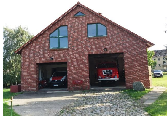
Abbildung 14 Tore Gerätehaus Grieben
