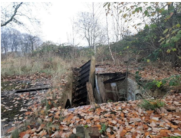
Abb. 4: Ruine mit Keller im Südwesten des Plangebietes, eigene Aufnahme.
