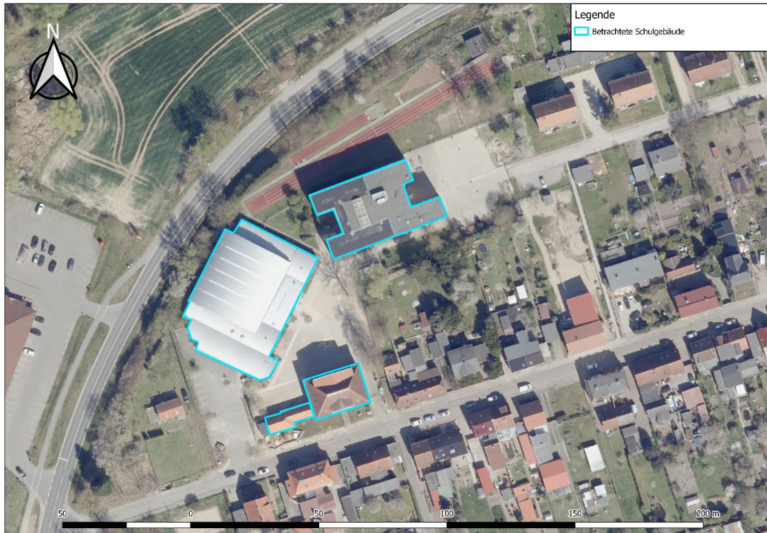
Abbildung 29: Schulkomplex der Grundschule und Regionalen Schule in der Rudolf-Breitscheid-Str. in Dassow
