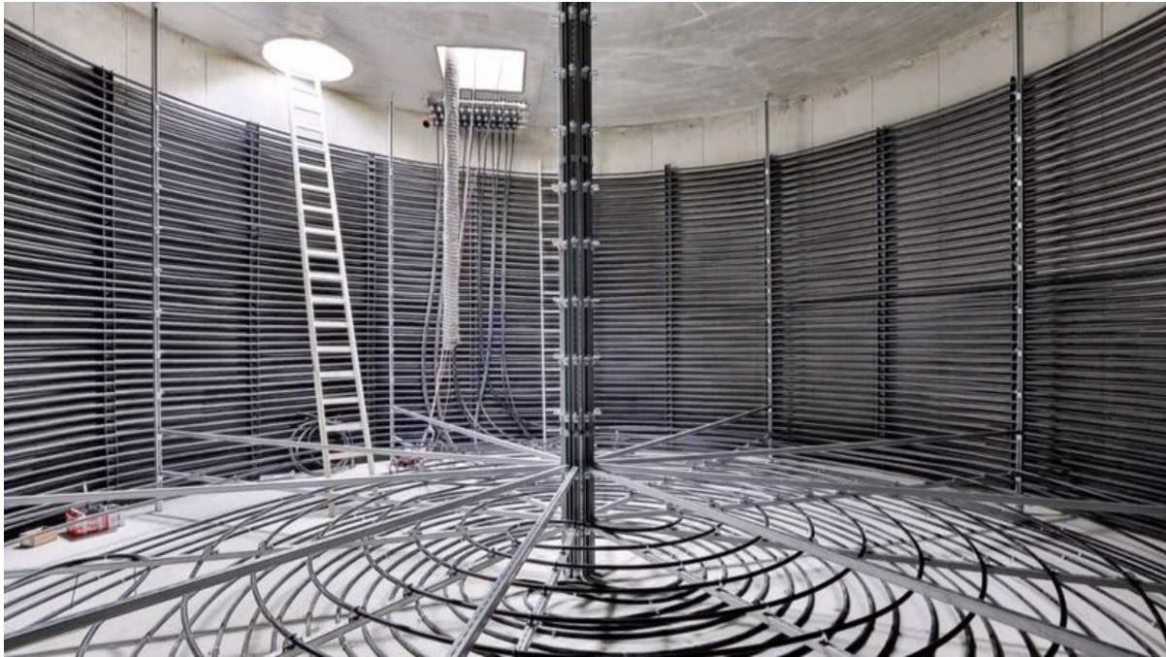
Abbildung 41: Innenansicht eines ungefüllten Eisspeichers mit Leitungsstruktur; Bundesverband Wärmepumpe e.V. bwp
