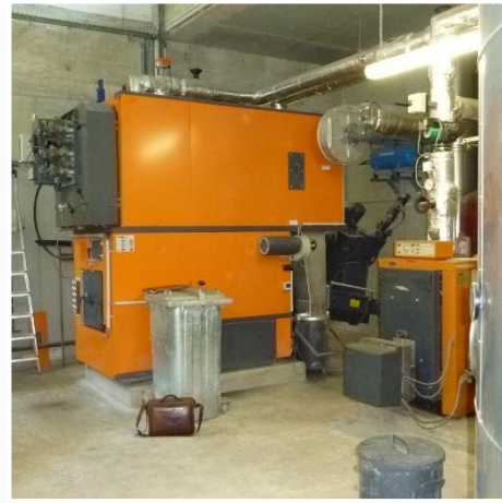
Abb. 39: Holz-Hackschnitzelkessel
