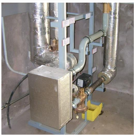
Abb. 42: Wärmeübergabestation
