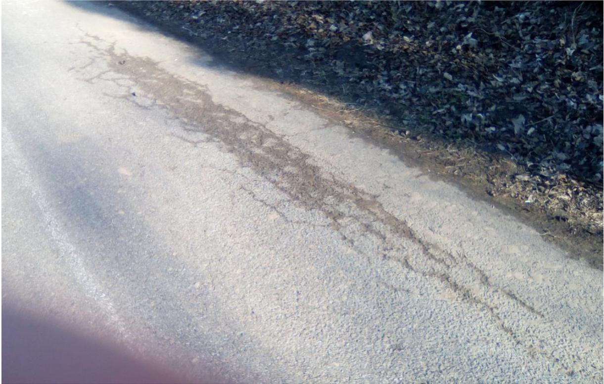
Netzrissige Struktur in der Fahrbahnoberfläche
