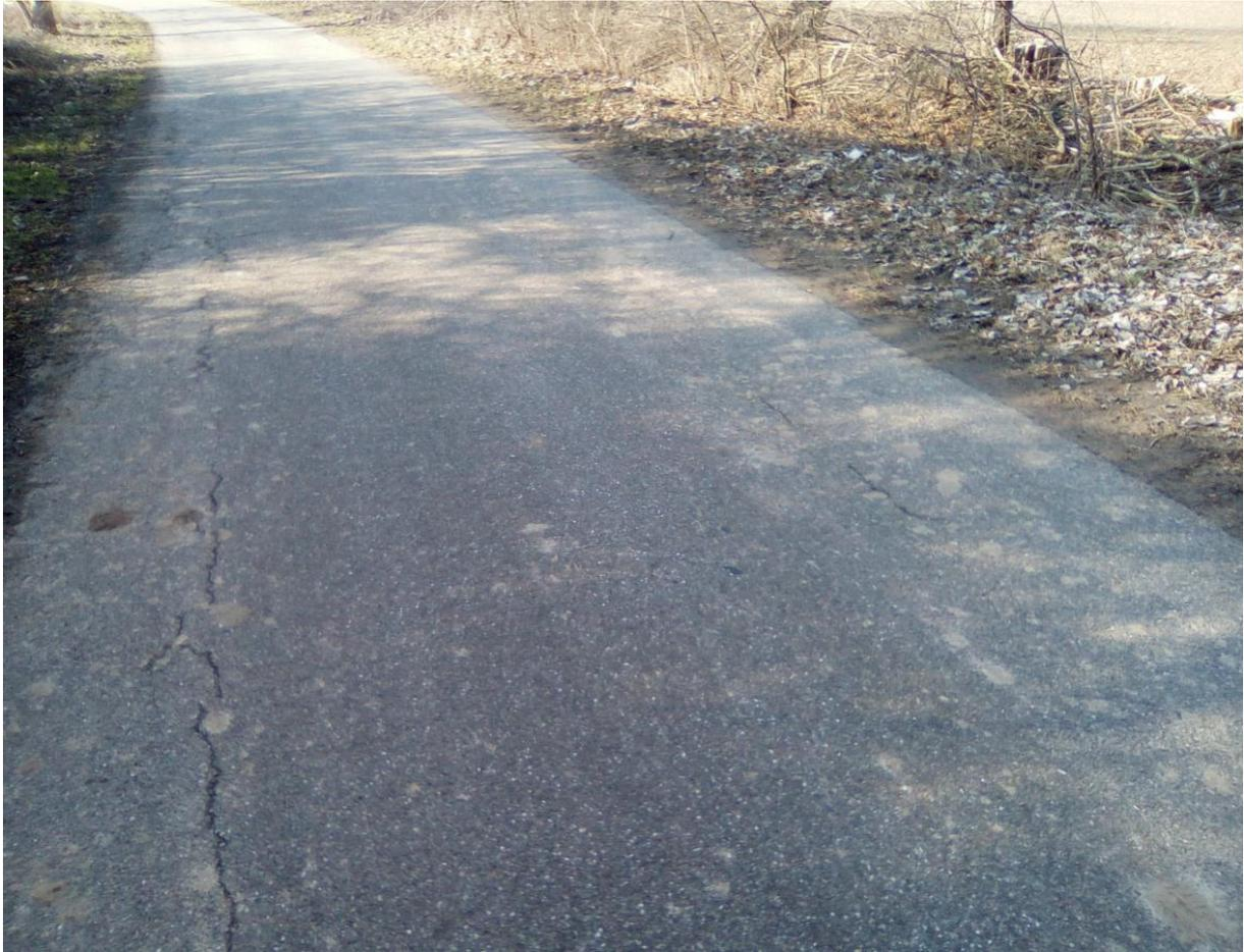
Längsrisse an den Fahrbahn­rändern über lange Strecken mit teilweise Netzrissigen Abschnitten
