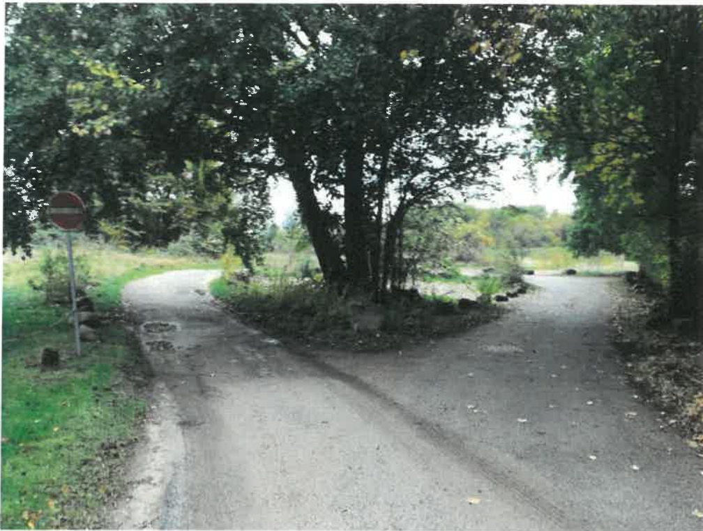
Abb. 1: Blick nach Norden zum geplanten Wendehammer
