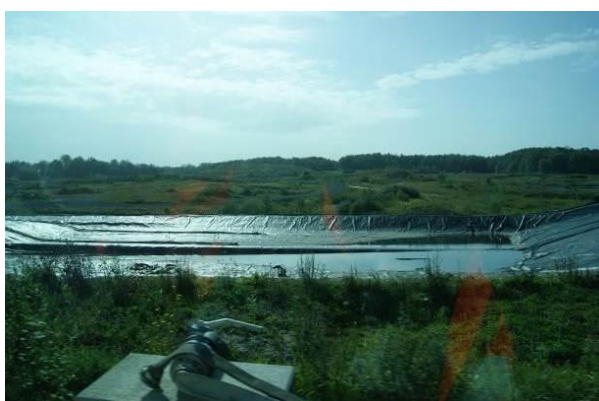
Foto 3: Sickerwasserbehandlungsbecken im östlichen Deponiegelände
