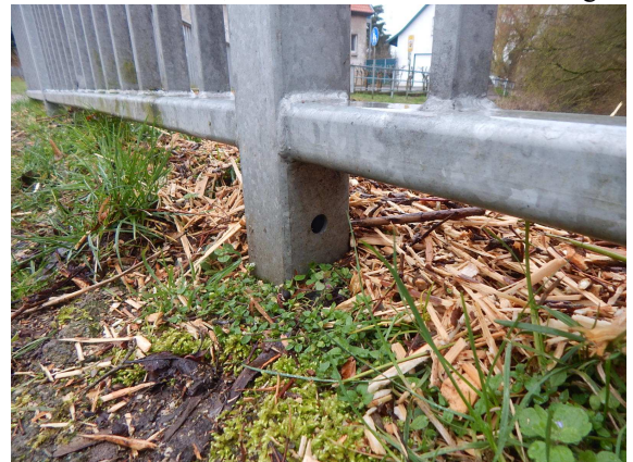
2131505_0_2020H_R-GEL PFOSTENFÜßE NICHT VERGOSSEN
