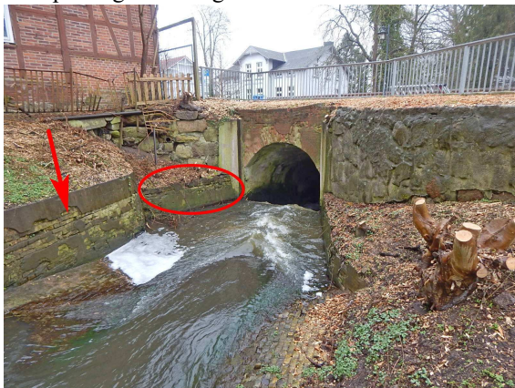
2131505_0_2020H_V-L-UFERMAUER BRÜCHIG
