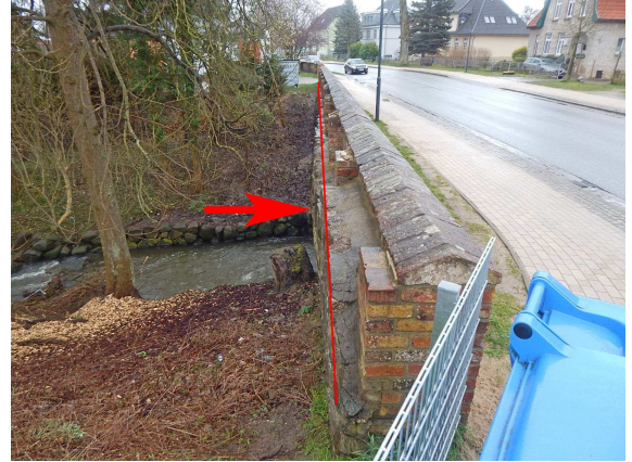
2131505_0_2020H_L-STW VORNE AUSGEBAUCHT
