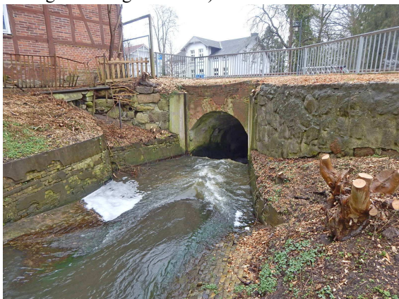
2131505_0_2020H_R-STW BEWUCHS ENTFERNT
