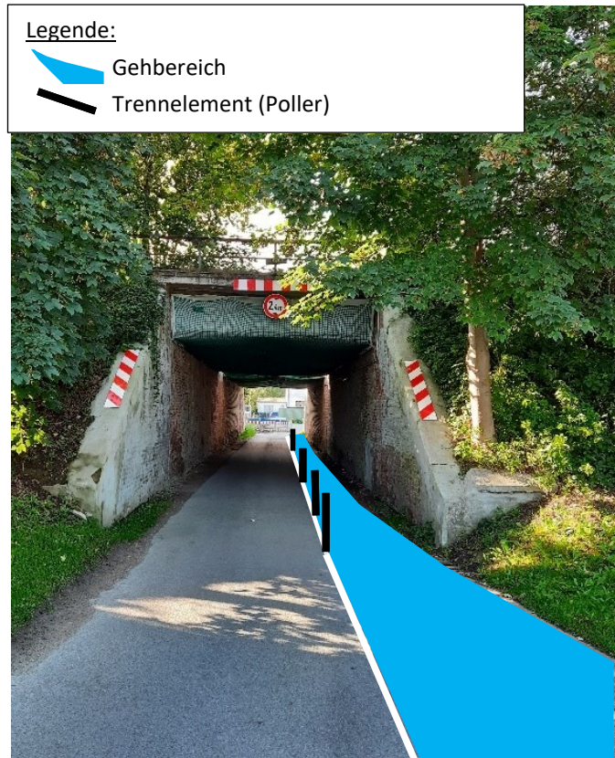
Abbildung 40: Fußgängerbereich Unterführung Bahnhofstraße Farbgebung dient zur Visualisierung
