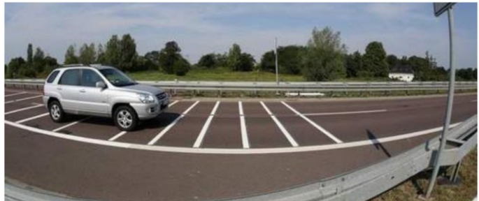
Abbildung 5: Beispiel einer optischen Flimmerbremse [17]
