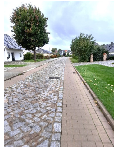
Abbildung 14: Beispiel für Radfahrbereiche auf Fahrbahnen mit Naturpflaster
