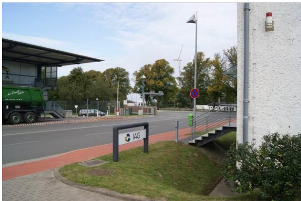
Foto 1: Eingangsbereich des Deponiegeländes aus nördlicher Sicht (B 104)
