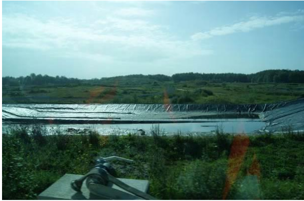
Foto 3: Sickerwasserbehandlungsbecken im östlichen Deponiegelände
