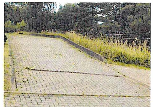
Dadurch besteht auf dieser Verkehrsfläche eine unzureichende Trittsicherheit. Es besteht dann die Gefahr des Umknickens, Fehltreten oder des Stolperns. Insbesondere in der Frost-/Tauperiode können sich in Senken Pfützen bilden, die dann gefährliche Rutschflächen darstellen.
