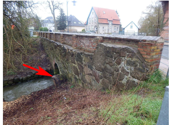
2131505_0_2020H_L-BÖSCH WL-V BAUM GEFÄLLT
