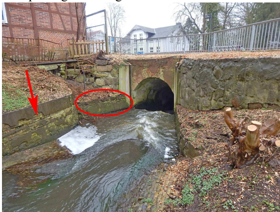
2131505_0_2020H_V-L-UFERMAUER BRÜCHIG
