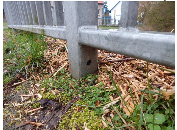
2131505_0_2020H_R-GEL PFOSTENFÜßE NICHT VERGOSSEN
