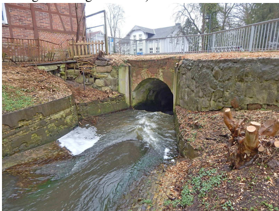
2131505_0_2020H_R-STW BEWUCHS ENTFERNT
