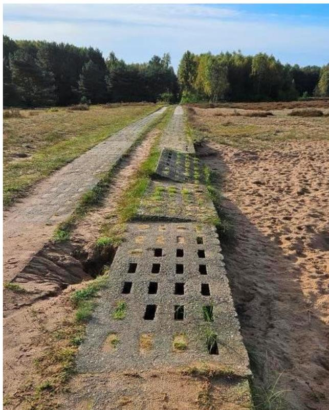
Abb. 58: Kolonnenweg mit defektem Belag (Foto tBL)
