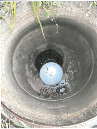
Dateiname: offensichtlicher Wassereinbruch unter der Deckenplatte.jpg
