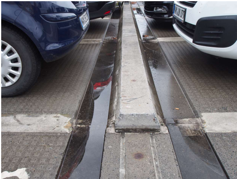
Abbildung 9, Entwässerungsrinnen in Deckenplatten
