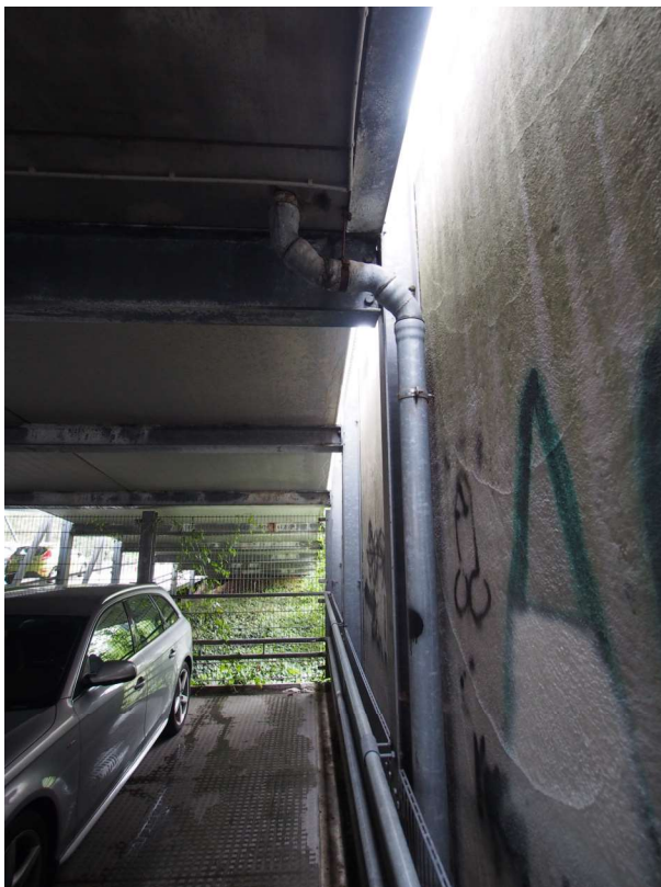
Abbildung 12, Fallrohr der oberen Entwässerung der Rampe
