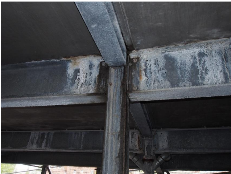
Typischer Knotenpunkt von Stützen und Deckenträgern
