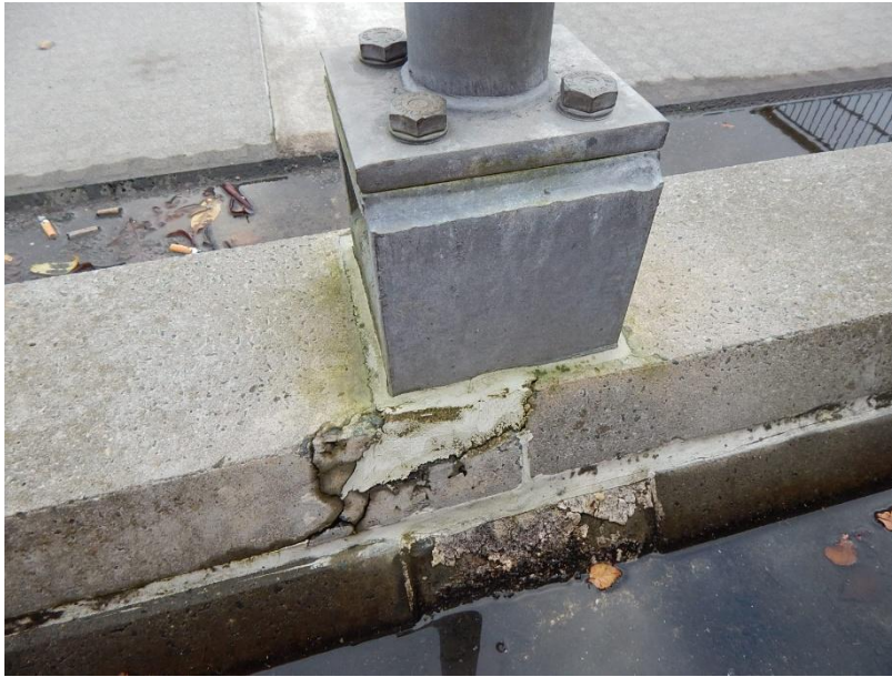
Beschädigter Schrammbord
