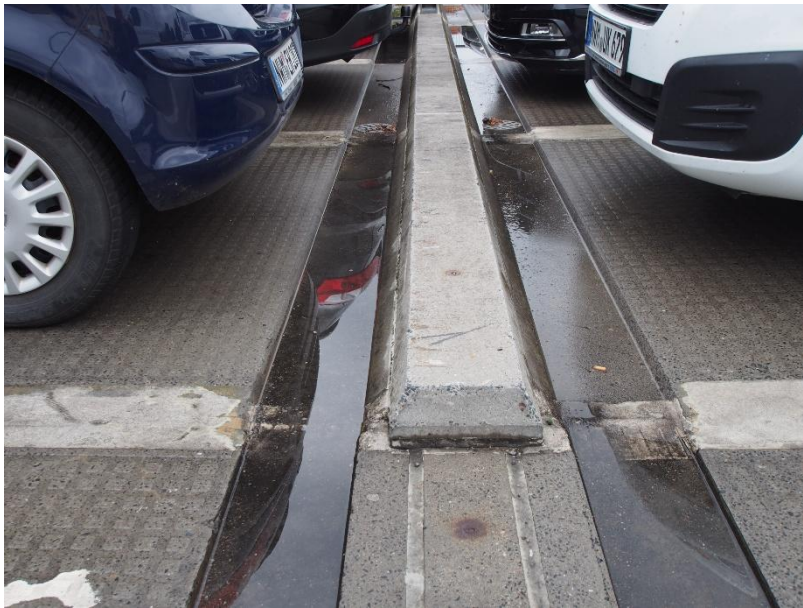
Entwässerungsrinnen in Deckenplatten
