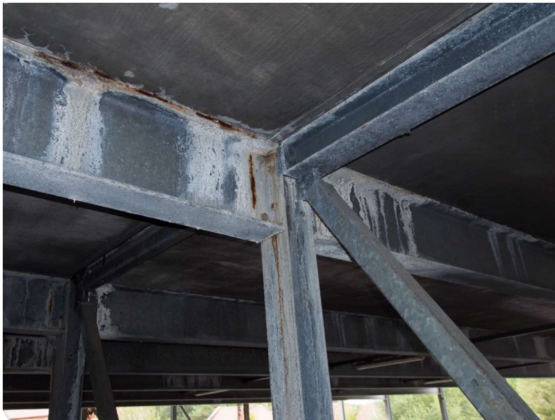
Abbildung 8, Deckenträger, Blattrostbildung am Obergurt
