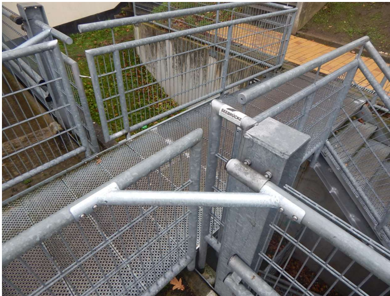
Abbildung 36, Geländer, Eckdetail
