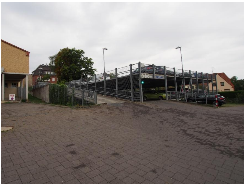
Schrägansicht Parkhaus von Süden
