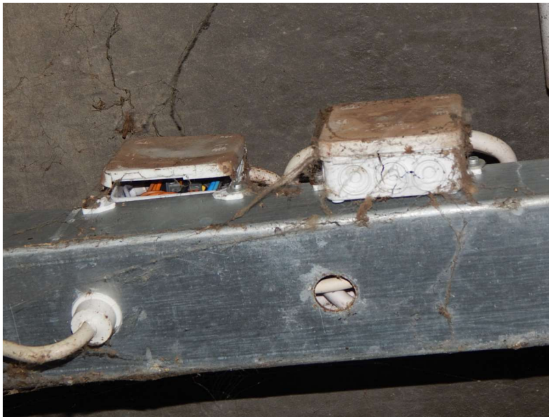
Abbildung 19, defekte Elektroanlagen
