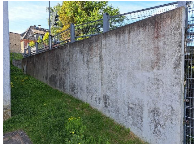
Stützwand Südseite (Außenansicht)
