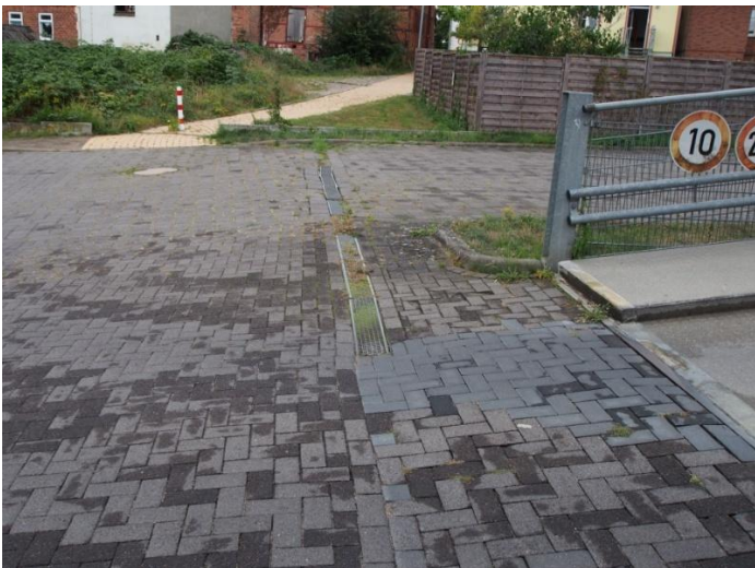
Fußpunkt der Rampe, Entwässerungsrinne defekt und verstopft und 08/2025 gekürzt und neu
