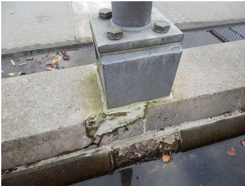
Abbildung 17, beschädigter Schrammbord
