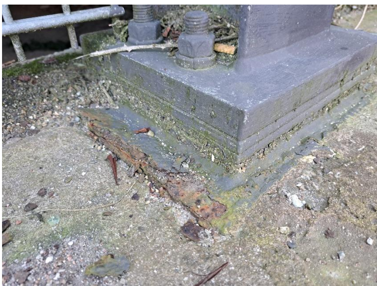
Fußplatten der Stützen, beginnende Blattrostbildung (Foto 08/2025)
