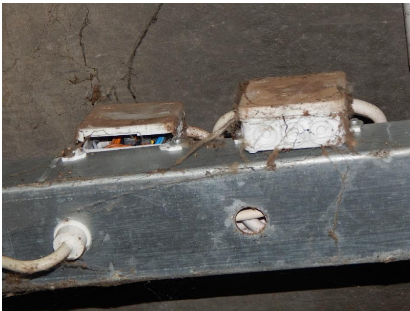
Defekte Elektroanlagen
