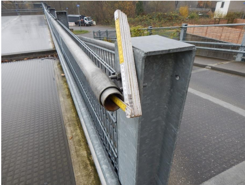
Geländer, offene Enden von Handläufen, Stand 08/2025 verschlossen (ohne Bild)
