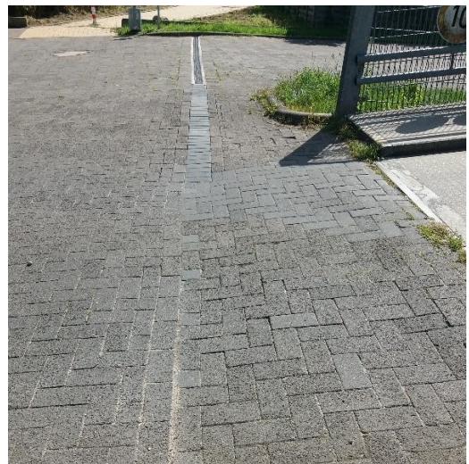
Fußpunkt der Rampe, Entwässerungsrinne defekt und verstopft und 08/2025 gekürzt und neu
