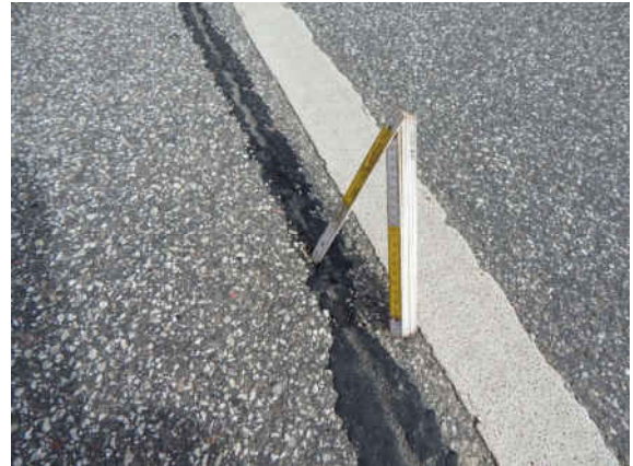
2131513_0_2022E_BELAG HINTEN MITTELNAHT AUFGERISSEN
