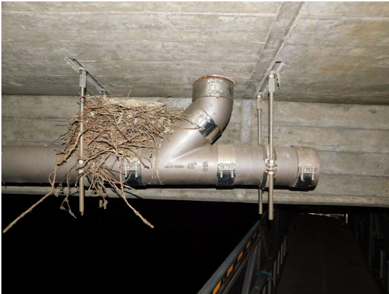
2131506_0_2019H_ENTW-LEITUNG HINTEN TAUBENNEST
