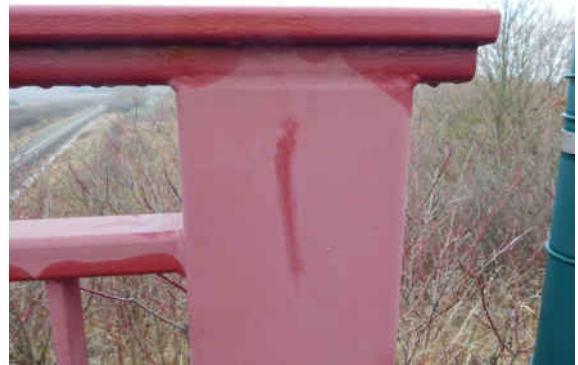
2131513_0_2019H_L-GEL HINTEN BESCHICHTUNG ABKREIDEND
