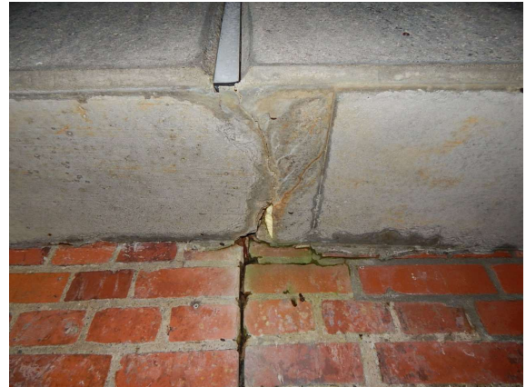
ASL_030_0_2025H_L-GESIMS VORNE RAUMFUGE MIT BETONBRÜCKE
