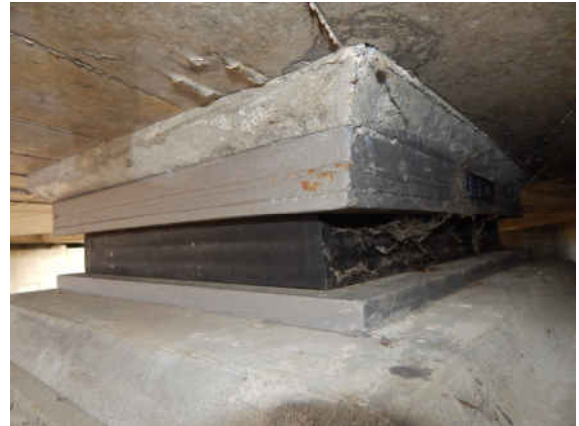
2131513_0_2019H_L-LAG WL-V VORNE OBEN LINKS ANGERÖSTET
