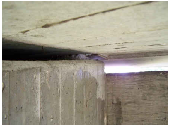
2131513_0_2009H_R-KRAGARM A-20 SCHALUNGSRESTE
