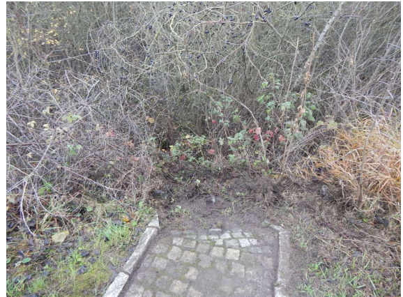
ASL_027_0_2025E_L-KASKADE WL-H STARK VERSCHMUTZT
