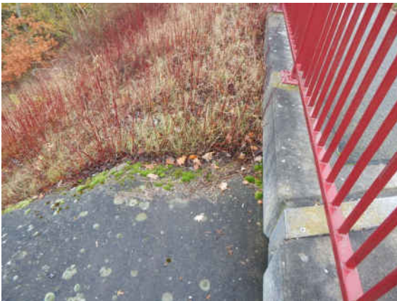
2131513_0_2025H_L-FL WL-H OBEN VERSCHMUTZT BEWACHSEN
