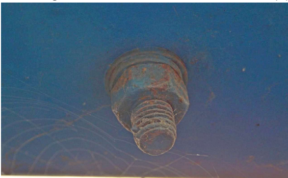
ASL_030_0_2013E_GEL HANDLAUF ANGEROSTET
