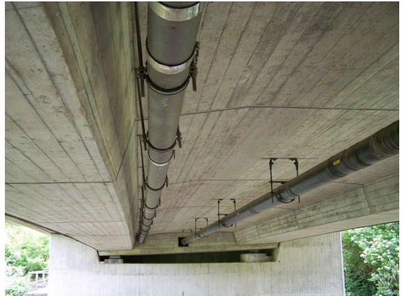
2131506_0_2009H_ENTW-LEITUNG SEITLICHE FESTPUNKTE FEHLEN
