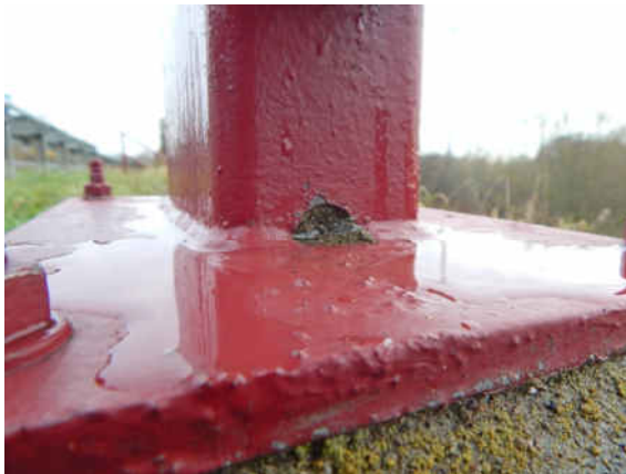
2131513_0_2025H_R-GEL ENTW-ÖFFNUNG HINTEN VERSTÖPFT
