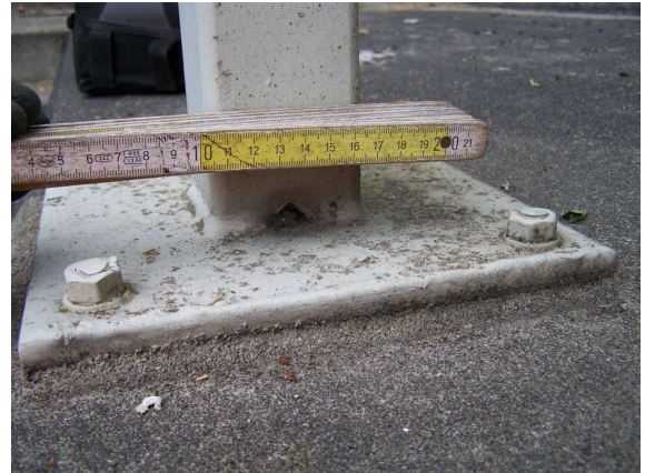
2131506_0_2009H_KONSOL-GEL VORNE RECHTS ENTW-OEFFNUNG ZU KLEIN
