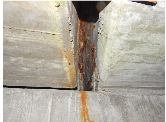
2131506_0_2025H_FÜK WL-V LINKS UNTEN VERROSTET
