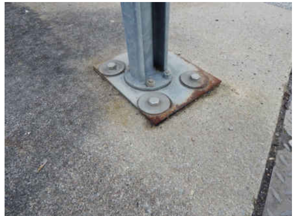
2131513_0_2022E_L-EDSP GRUNDPLATTE ANGEROSTET
