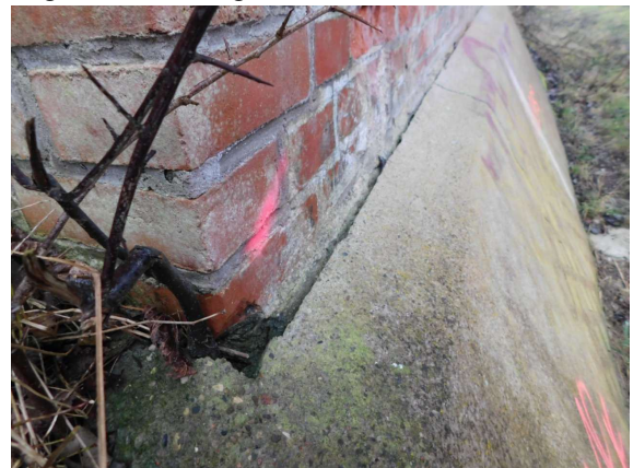
ASL_030_0_2017H_BETONKRANZ WL-V ABGEDRÜCKT
