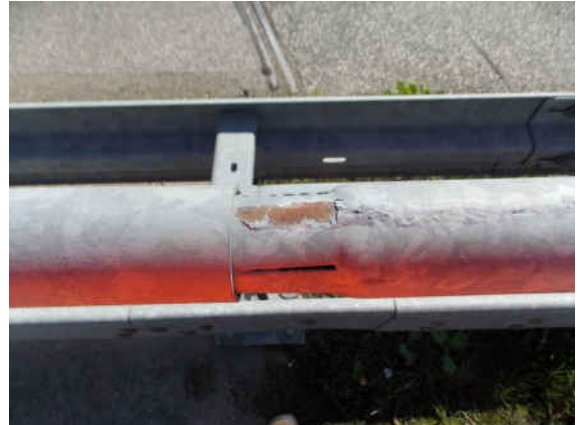
2131513_0_2013E_AUFSATZGELÄNDER KORRODIERT
