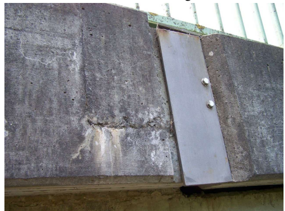
2131506_0_2009H_L-GESIMS A-20 AUSSINTERUNGEN
