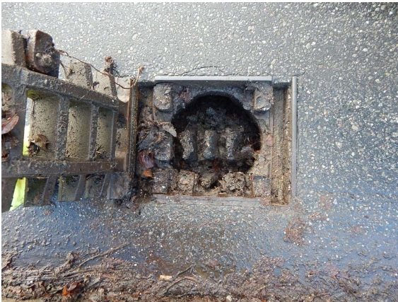
2131506_0_2025H_V-ABLAUF VERSCHMUTZT
