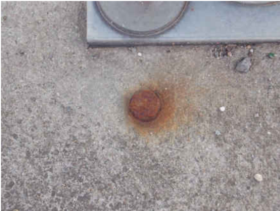
2131513_0_2013E_KORRODIERTER ERDUNGSANSCHLUSS
