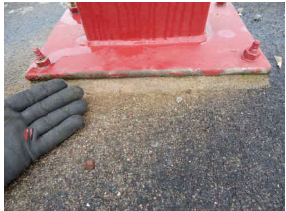
2131513_0_2025H_L-GEL MITTIG BESCHICHTUNG ABGEPLÄTZT
