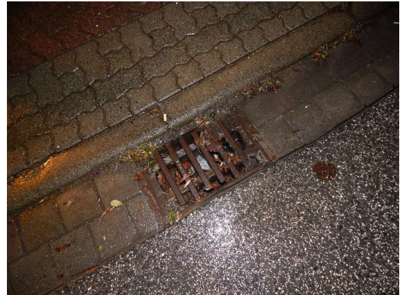
2131506_0_2019H_V-STRABENABLAUF LINKS NICHT VERSCHLIEßBAR
