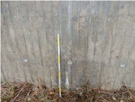
2131513_0_2022E_R-FL WL-H RISS MIT AUSSINTERUNGEN
