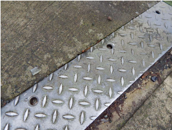
2131506_0_2019H_FUK VORNE RECHTS SCHRAUBEN ABGESCHERT
