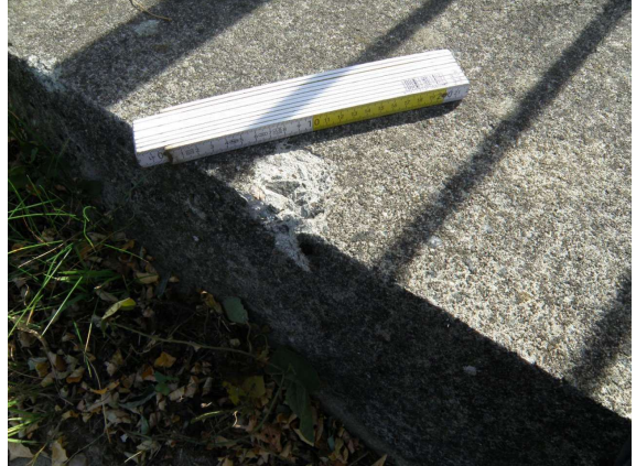
ASL_027_0_2016H_R-KAPPE HINTEN ABPLATZUNG
