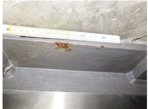
2131506_0_2019H_2009H_L-LAG WL-2 OBEN ANGEROSTET
