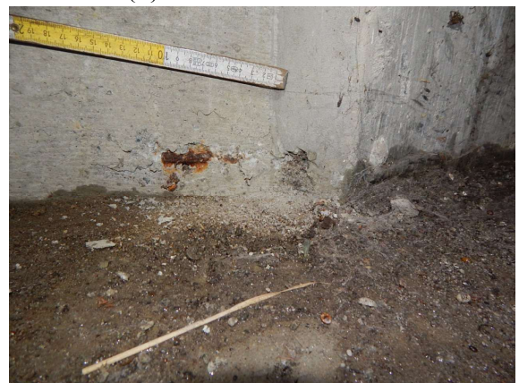
2131506_0_2019H_AUFL-BANK WL-V INNEN RECHTS BEWEHRUNG
