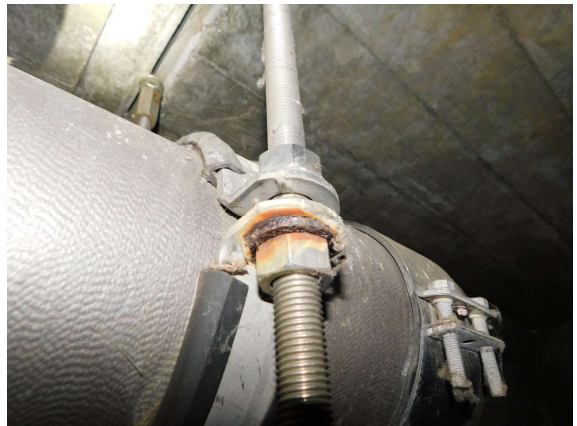
2131506_0_2019H_ENTW-LEITUNG HINTEN U-SCHEIBE ROSTIG
