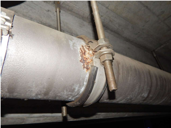
2131506_0_2025H_ENTW-LEITUNG VORNE UNTERRÖSTUNGEN
