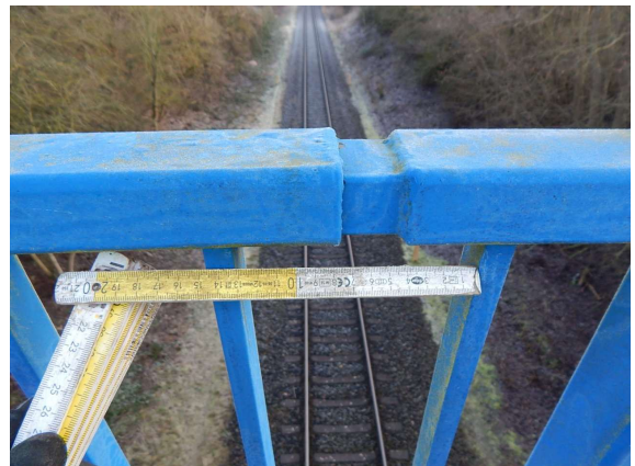
ASL_030_0_2022E_R-GEL MITTIG FÜLLSTABABSTAND ZU GROß
