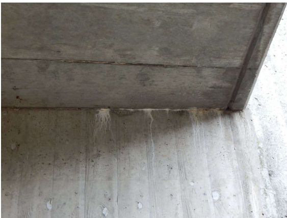
2131506_0_2025H_R-FL WL-V KONSOLE AUSSINTERUNGEN
