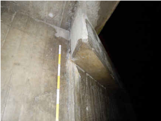
2131513_0_2019H_GESIMS L-FL WL-V ANSATZ AUSSINTERUNGEN
