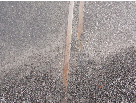
2131506_0_2013E_FUK BESCHICHTUNG ABGEFAHREN
