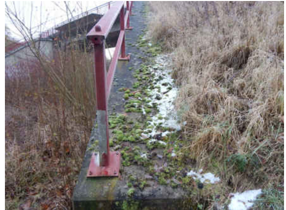
2131513_0_2025H_KAPPE L-FL WL-V BEMOOST ÜBERWACHSEN
