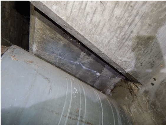
2131506_0_2019H_KONSOLE K-WAND WL-H RISS AUSSINTERUNGEN
