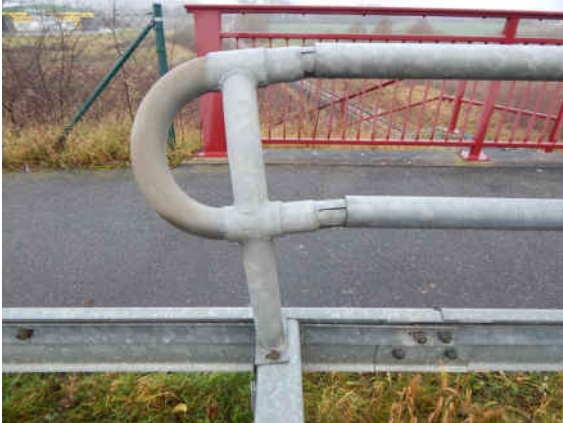
2131513_0_2019H_L-EDSP VORNE ENDSCHWINGE VERKANTET
