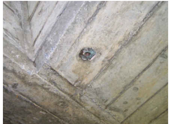
2131513_0_2009H_ERDUNGSBUCHSE OFFEN
