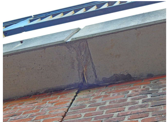
ASL_030_0_2022E_L-KAPPE VORNE RF MIT AUSSINTERUNGEN
