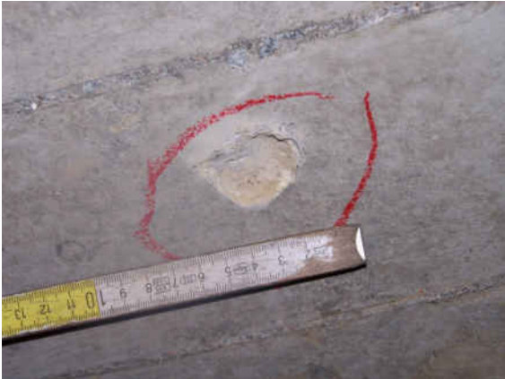
2131513_0_2009H_R-KRAGARM MITTE SANDEINSCHLUSS
