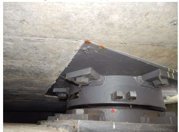
2131506_0_2025H_R-LAG WL-H OBEN UNTERROSTUNGEN
