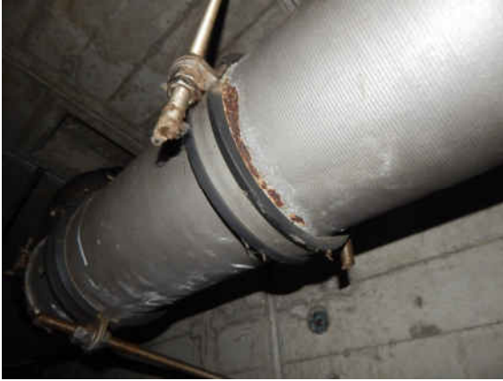
2131513_0_2025H_ENTW-LEITUNG VORNE RECHTS UNTERRÖSTUNGEN
