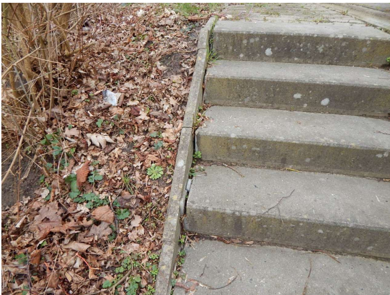
2131506_0_2022E_R-TREPPE WL-V OBEN R-WANGE ABGEKIPPT
