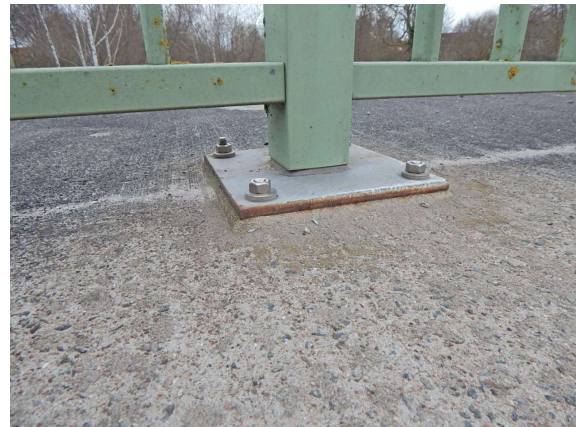
2131506_0_2022E_L-GEL FUßPLATTE ANGEROSTET
