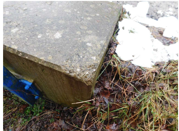
ASL_030_0_2017H_L-KAPPE VORNE ABPLATZUNG
