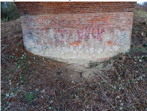
ASL_030_0_2022E_BÖSCH VOR WL-H HERUNTERGETRETEN AUSGESPÜLT
