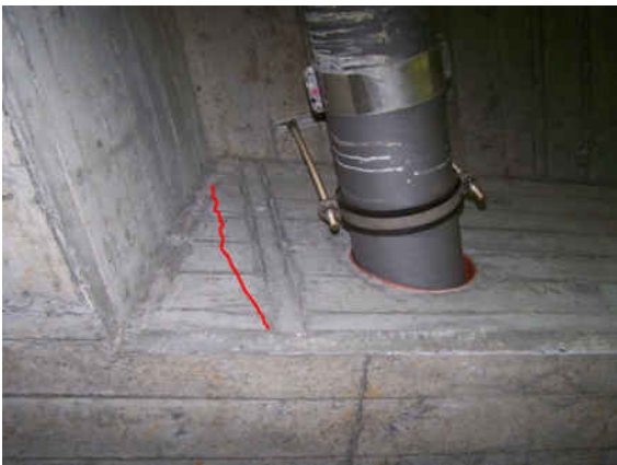
2131513_0_2009H_EQT A-10 RECHTS GERISSEN
