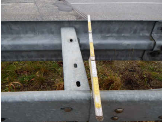
2131513_0_2019H_L-EDSP HINTEN D-STÜCK VERDREHT
