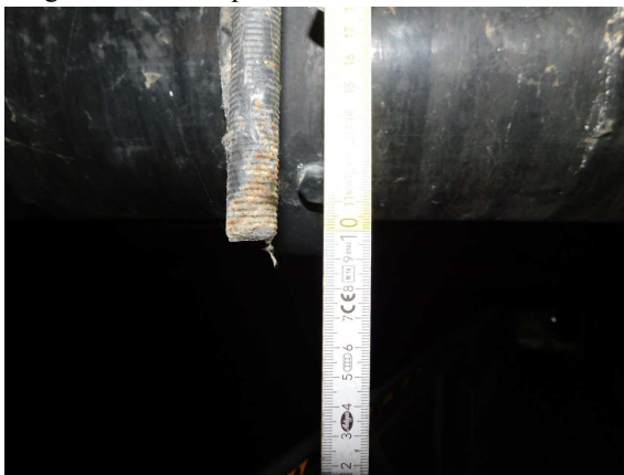
2131506_0_2019H_GASLEITUNG GEWINDESTANGEN ANGERÖSTET
