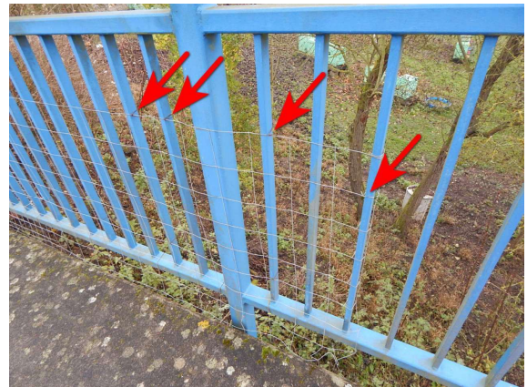
ASL_027_0_2025E_R-GEL HINTEN BEFESTIGUNG MASCHENDRAHT
