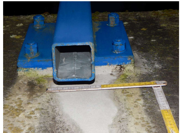
ASL_032_0_2019H_L-GEL PF-7 UNTERSTOPFUNG UNTEN UNVOLLSTÄNDIG
