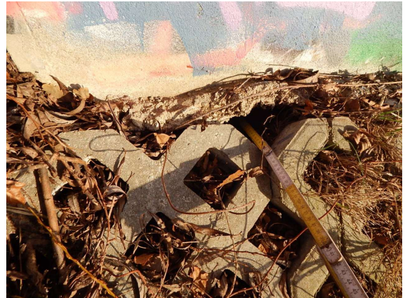
ASL_032_0_2019H_WL-V RECHTS UNTERHÖLT
