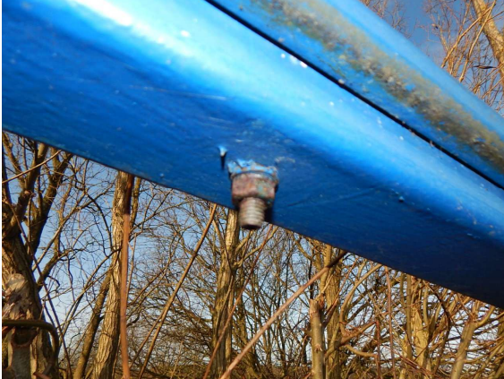
ASL_032_0_2019H_R-GEL VORNE UNTEN SCHRAUBE ROSTIG
