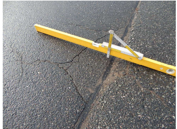
ASL_032_0_2022E_FAHRBAHN HINTER BAUWERK VERSACKUNG
