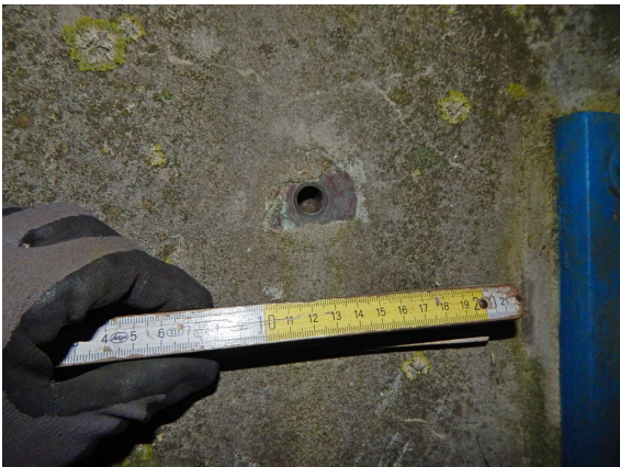
ASL_032_0_2025H_ERDUNGSBUCHSE OFFEN BOLZEN FEHLT
