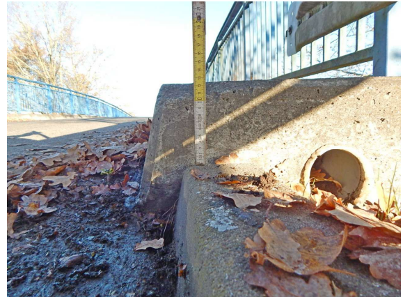
ASL_032_0_2025H_L-BORD HINTEN BORDSTEIN VERSACKT
