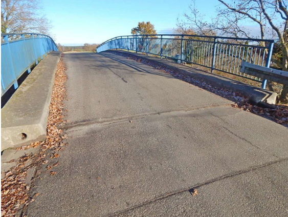
ASL_032_0_2025H_BELAG VOR DEN BORDEN LAÜBVERSCHMUTZUNGEN
