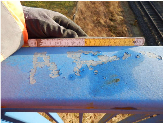
ASL_032_0_2019H_L-GEL VORNE BESCHICHTUNG BLÄTTERT AB
