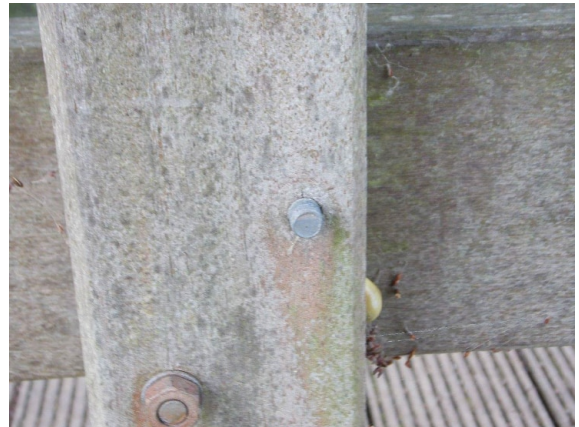
ASL_002_0_2013E_R-GEL PF-2 MUTTER FEHLT
