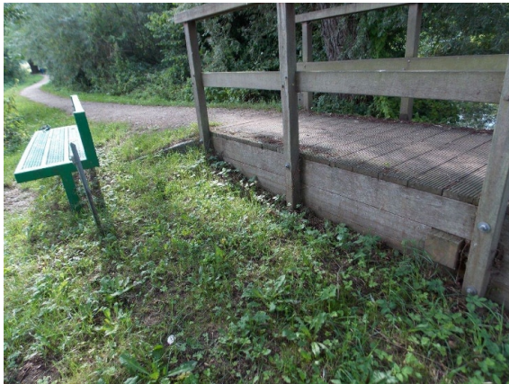
ASL_002_0_2013E_R-TRÄGER VORNE ERDKONTAKT
