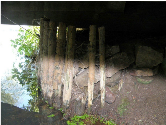
ASL_002_0_2009H_WL-V BOESCHUNGSSICHERUNG UNWIRKSAM
