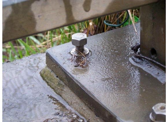
2131501_0_2009H_L-GEL HINTEN LOSE MUTTERN
