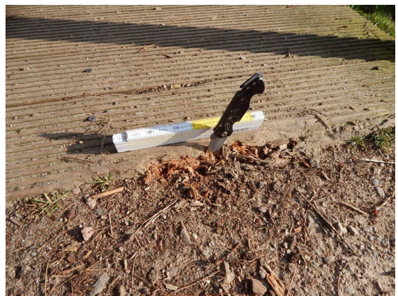
ASL_002_0_2020E_BELAG VORNE BOHLE ANGEFAULT
