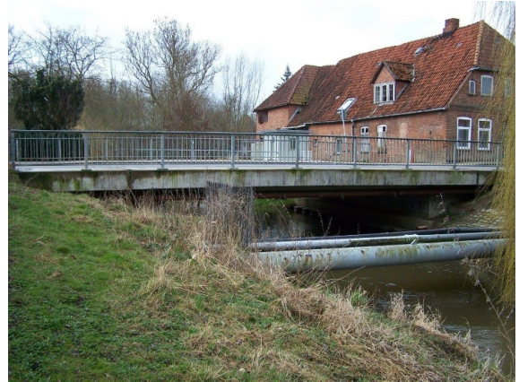
2131501_0_2009H_BÖSCHUNGSTREPPE FEHLT
