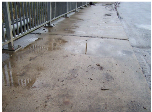
2131501_0_2009H_L-KAPPE UNEBEN MIT PFÜTZENBILDUNG
