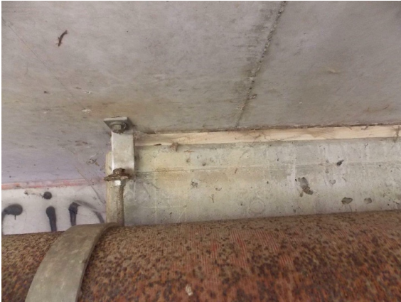
2131501_0_2013E_L-FL WL-V SCHALUNG NICHT AUS FÜGE ENTFERNT
