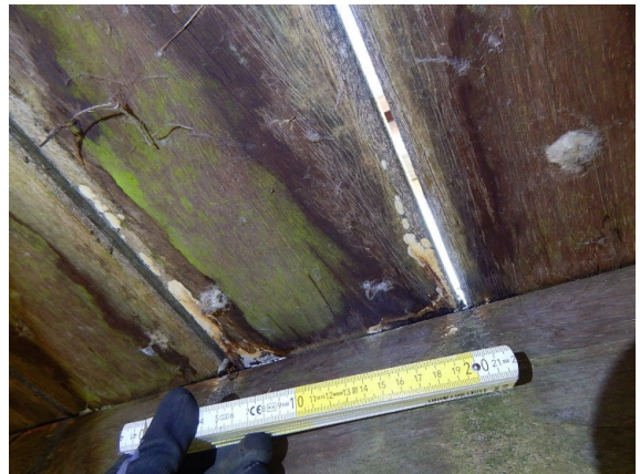
ASL_002_0_2020E_BELAG MITTIG RECHTS PILZMYZEL
