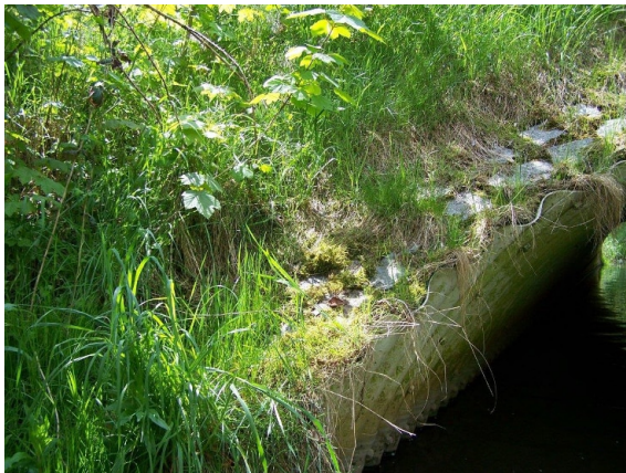
ASL_029_0_2012E_L-STIRNRING HINTEN ÜBERWACHSEN
