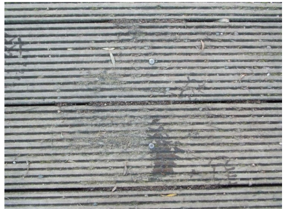
ASL_002_0_2013E_BELAG FUGEN ZUGESANDET
