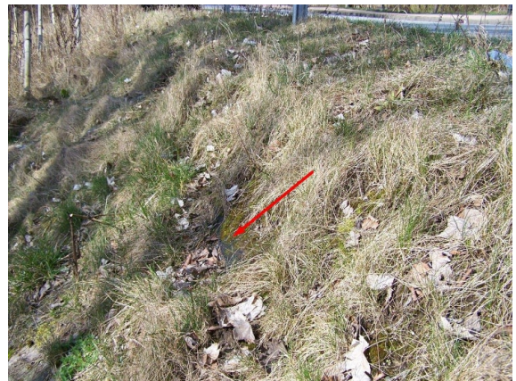
ASL_029_0_2009H_R-BÖSCH ZU STEIL
