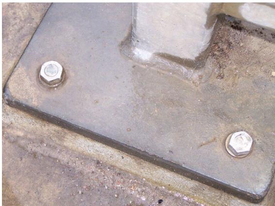
2131501_0_2009H_L-GEL ANKER ABGESCHNITTEN
