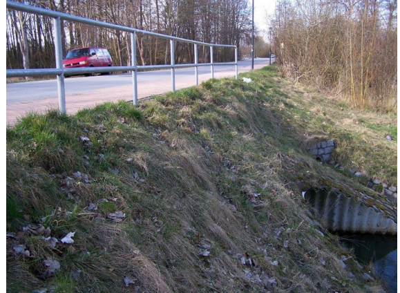
ASL_029_0_2009H_L-BÖSCH ZU STEIL
