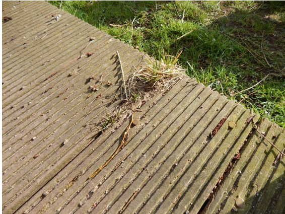
ASL_002_0_2020E_BELAG VORNE RECHTS FUGEN BEWACHSEN
