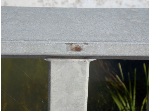
2131501_0_2013E_L-GEL HANDLAUF MITTIG ANGERÖSTET
