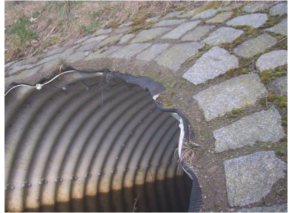
ASL_029_0_2009H_R-STIRNRING VLIES NICHT ENTFERNT
