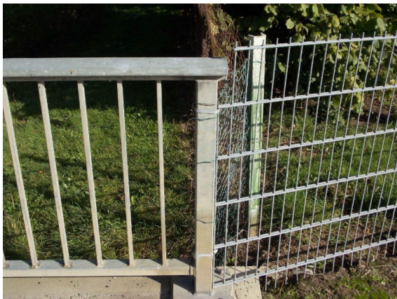
2131501_0_2013E_L-GEL HINTEN ZAUNANSCHLUSS NICHT FACHGERECHT
