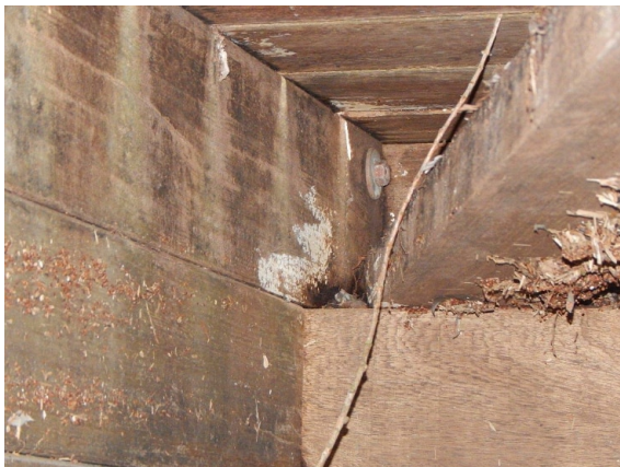
ASL_002_0_2020E_L-LT HINTEN RECHTS PILZMYZEL
