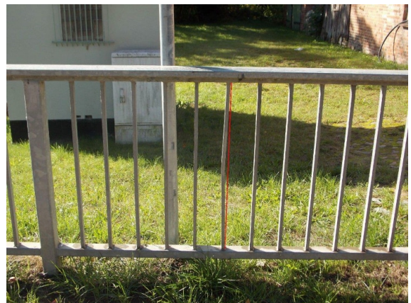
2131501_0_2013E_R-GEL VORNE VERBOGENER FÜLLSTAB
