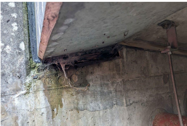
2024E_RAUMFUGE FLÜGEL VORNE RECHTS WASSERFÜHREND
