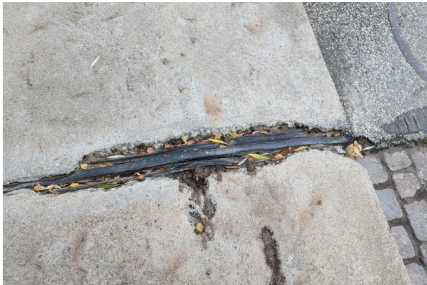
2024E_L-KAPPE V-FUGE FLANKEN ABBRUCH
