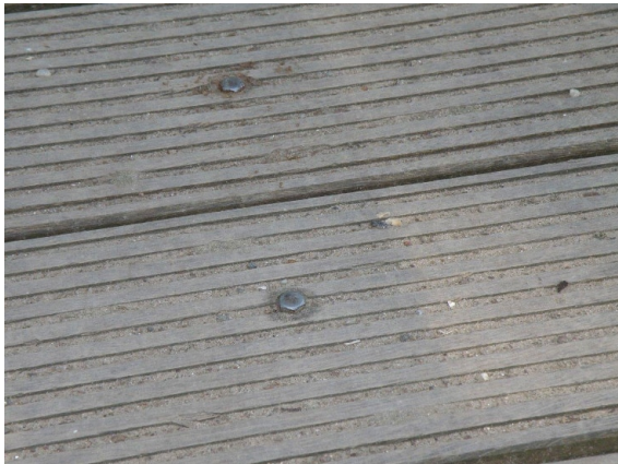
ASL_002_0_2009H_BELAG_VORSTEHENDE_VERSCHRAUBUNG
