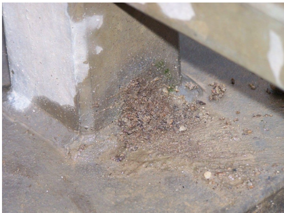
2131501_0_2009H_L-GEL ENTW-ÖFFNUNG VERSANDET
