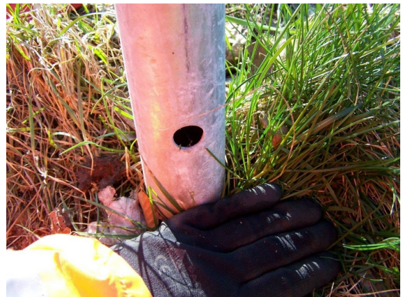
ASL_029_0_2009H_L-GEL PFOSTENVERGUSS FEHLT
