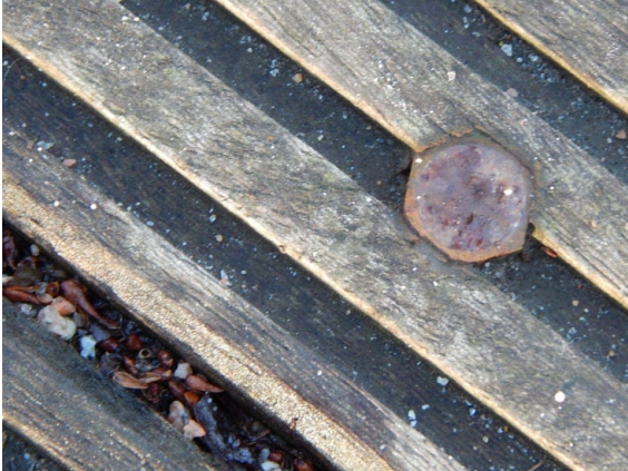
ASL_002_0_2015H_BELAG SCHRAUBEN ANGERÖSTET
