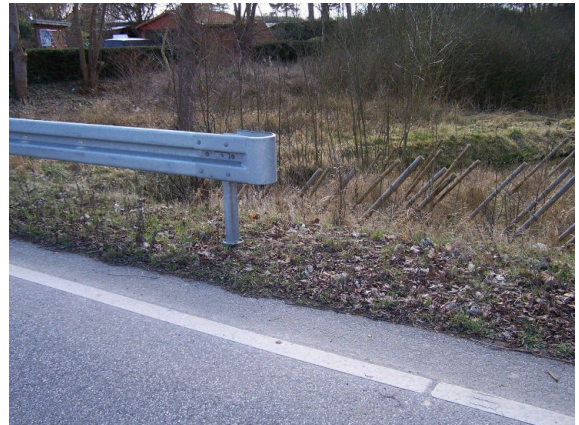
ASL_029_0_2009H_R-SPL VORNE ABSENKER FEHLEN
