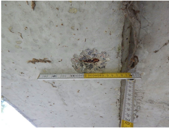
2131501_0_2020H_L-GESIMS VORNE BEWEHRUNG
