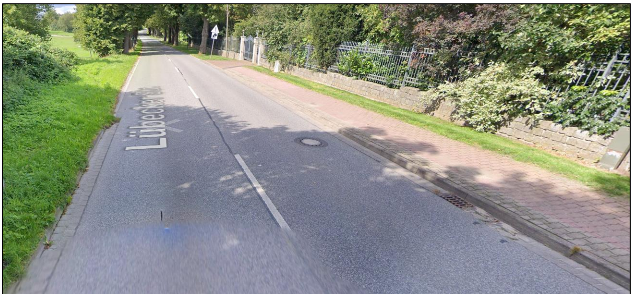
Bild 4: Lübecker Straße, Beginn Grundstück Haus Nr. 49 mit Darstellung des letzten angeschlossenen Straßenablaufes vor der Behandlungsanlage (Ende Einzugsgebiet Lübecker Straße)
