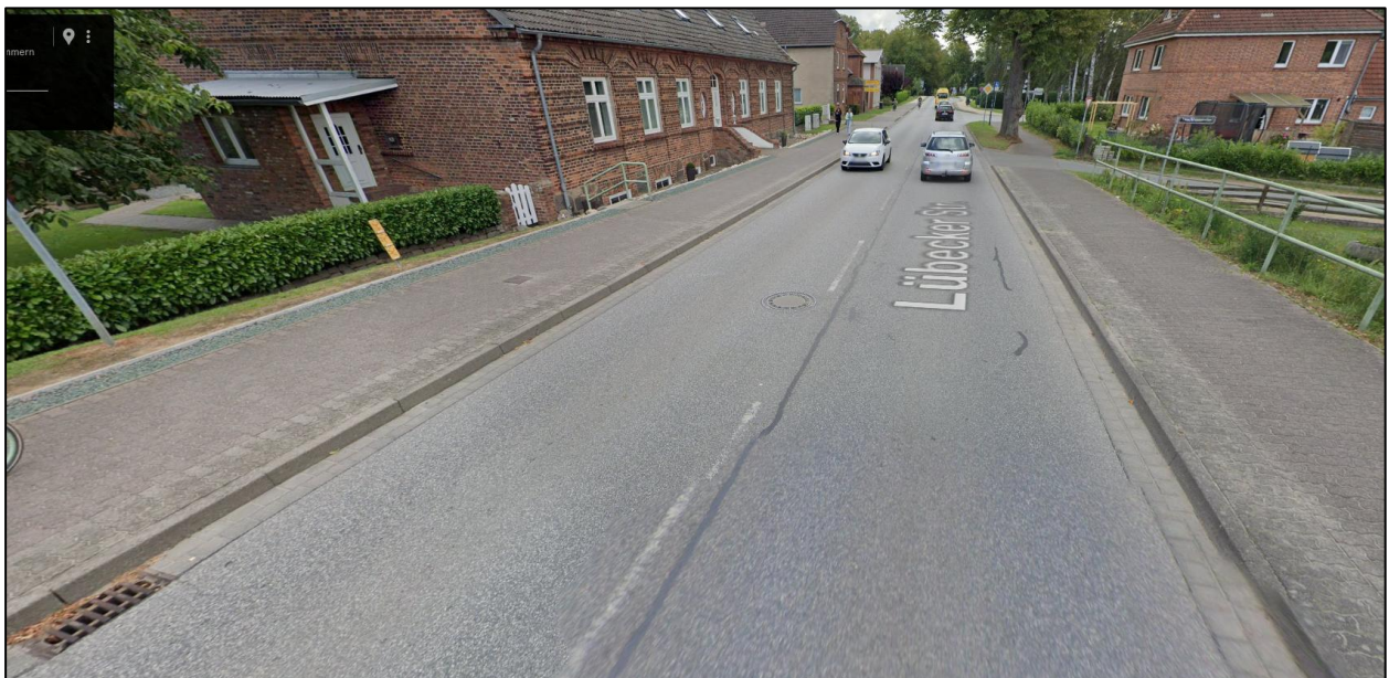
Bild 1: Lübecker Straße, Haus Nr. 43, mit Darstellung des letzten angeschlossenen Straßenablaufes vor der Bahnbrücke (Beginn Einzugsgebiet Lübecker Straße)
