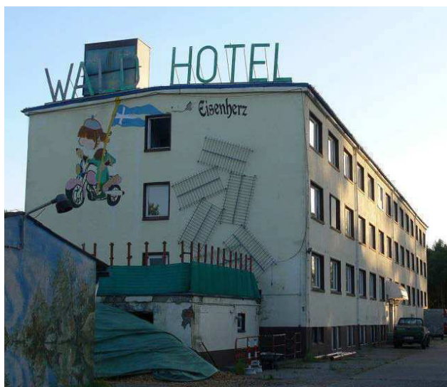
Abb. 3: Zum Abriss vorgesehene Gebäude mit wenig Quartiermöglichkeiten für Fledermäuse
