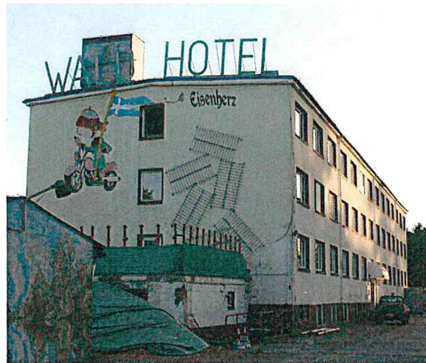
Abb. 3: Zum Abriss vorgesehenes Gebäude mit wenig Quartiermöglichkeiten für Fledermäuse
