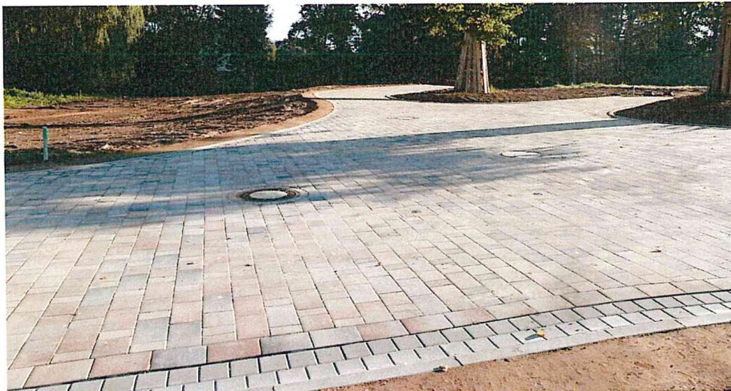
Wohngebiet in Naschendorf; Pflasterung mit Modula Plus Formatmix muschel/sand nuanciert; Randausbildung mit Läuferreihe und Bord bzw. Pflastergasse aus Betongossenläufern zur Entwässerung
