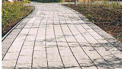
Reststreifen und Rinne aus Kleinpflastersteine nach DIN EN 1342, 90/90/90 mm, Oberfläche gespalten, F1, T2, Verlegung im Netzverband, (Rinne im Läuferverband), Material: Granit, Farbe: grau.
