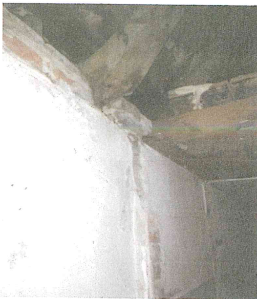
akuter Schwammschaden im vorderen Teil Decke + Sparren
