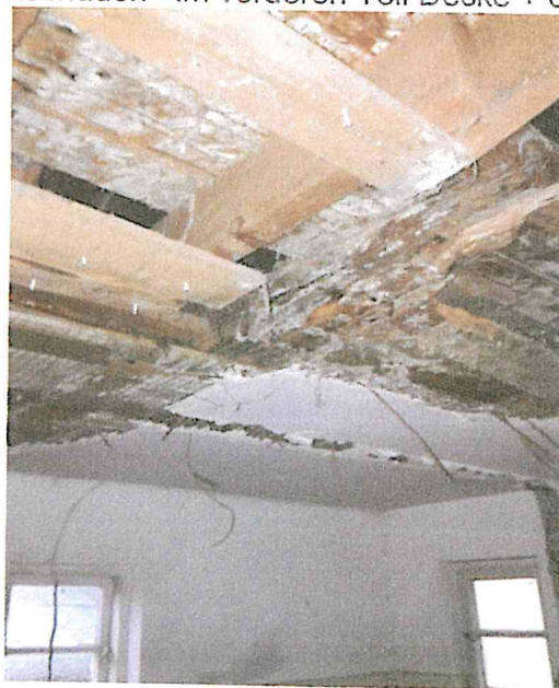
akuter Schwammschaden im vorderen Teil Decke + Sparren
