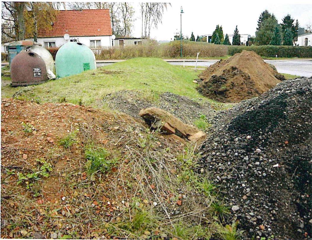
Anschüttung des vorhandenen Walles mit Recyclingschotter
