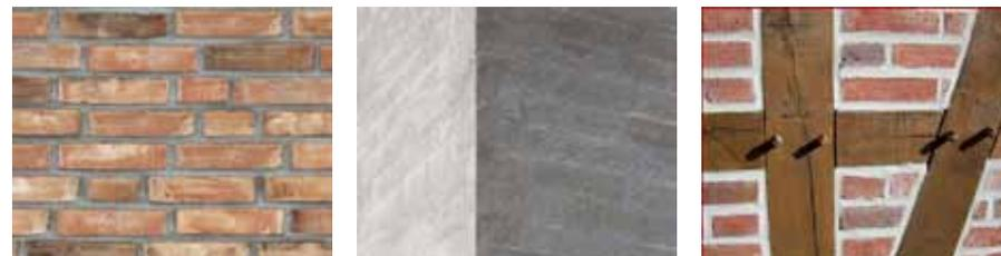
Abb. 34 | zulässige Ziegelfassaden | Sichtmauerwerk, MW geschlemmt/ verputzt, Fachwerk
