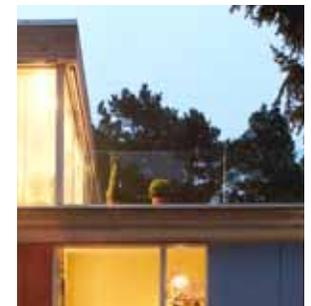
Abb. 53 | Brüstungen aus Fassadenmaterial, Stahl oder Glas
