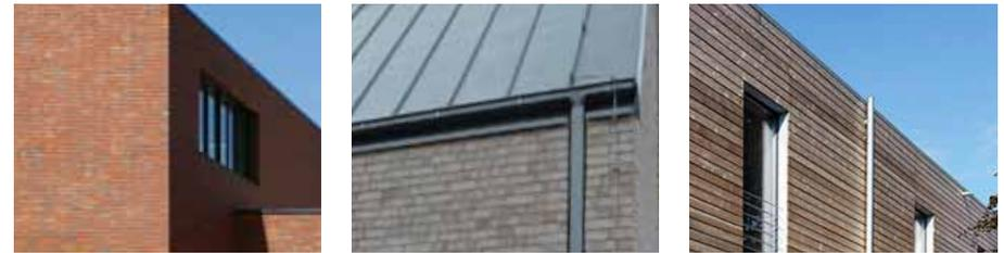
Abb. 22 | Dachentwässerung | innenliegend | fassadenbündig | schlicht, fassadenaufgesetzt
