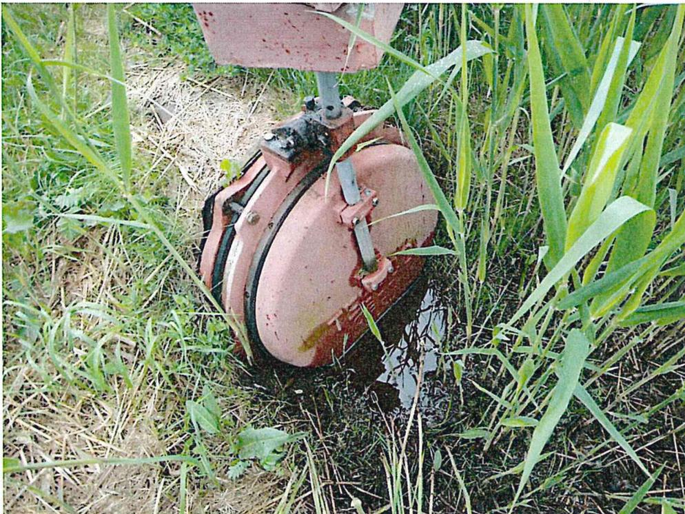
Abb.3 Foto Rückstauklappe
