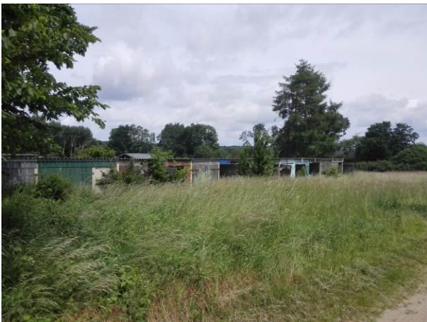
Ortsbildstörende Garagenanlage im westlichen Plangebiet.
