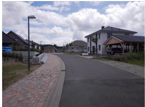
Inzwischen abgeschlossene bauliche Entwicklung im Wohngebiet "Am Mühlenbruch".
