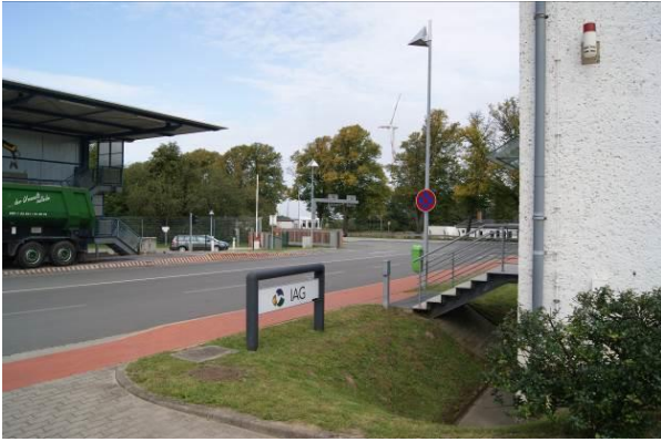
Foto 1: Eingangsbereich des Deponiegeländes aus nördlicher Sicht (B 104)
