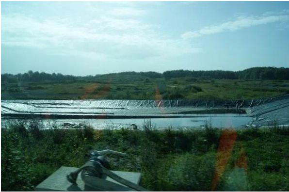
Foto 3: Sickerwasserbehandlungsbecken im östlichen Deponiegelände
