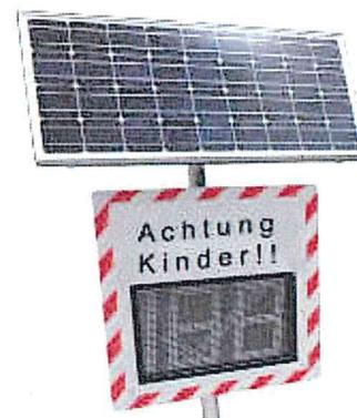
Solarpanel zur Stromversorgung
