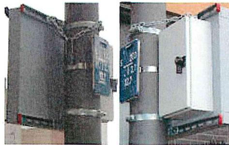
Rückansicht des montierten Displays, hier ohne Frontschild
