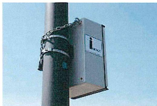
Fertig montierte Rückansicht inkl. Diebstahlschutz
