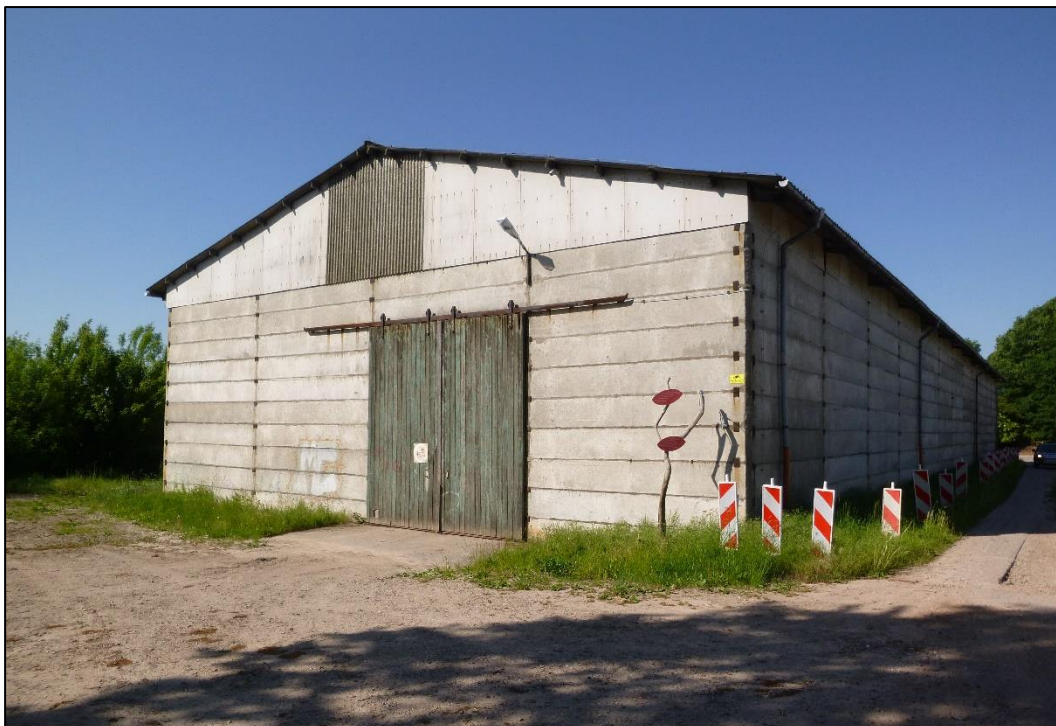
Abbildung 3: Ansicht des Rolltores der Fahrzeughalle, an dem der Anflug eines Spaltes durch zwei Fledermäuse erfolgte
