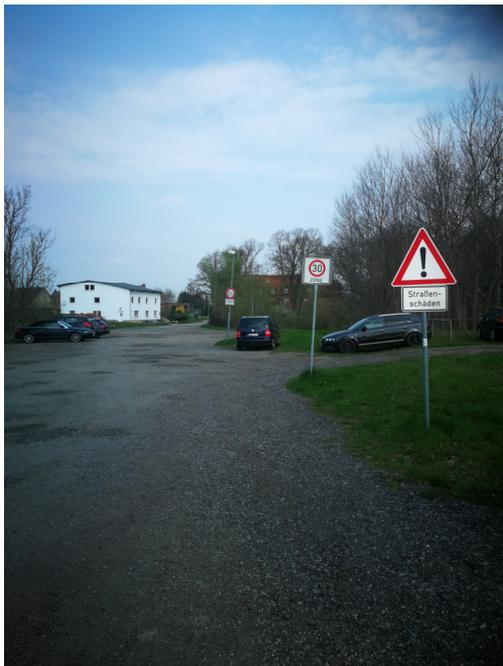
Der zu überplanende Abschnitt ist in einem bautechnisch schlechten Zustand. Eine funktionsfähige Entwässerung ist nicht vorhanden, so dass es zu großflächigen Ansammlungen von Oberflächenwasser kommt, welche die Nutzungsfähigkeit weiter beeinträchtigen und zu Schäden führen.
