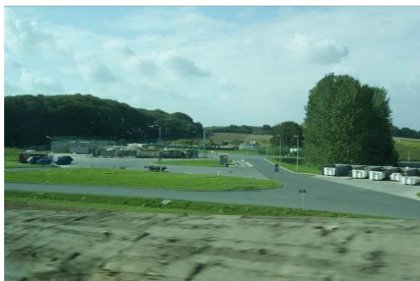
Foto 6: Versiegelte Verkehrs- und temporäre Lagerflächen innerhalb des Deponiegeländes
