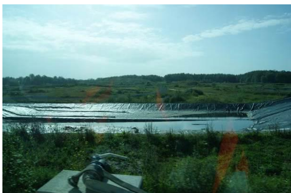
Foto 3: Sickerwasserbehandlungsbecken im östlichen Deponiegelände
