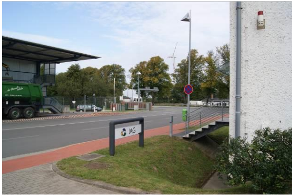
Foto 1: Eingangsbereich des Deponiegeländes aus nördlicher Sicht (B 104)
