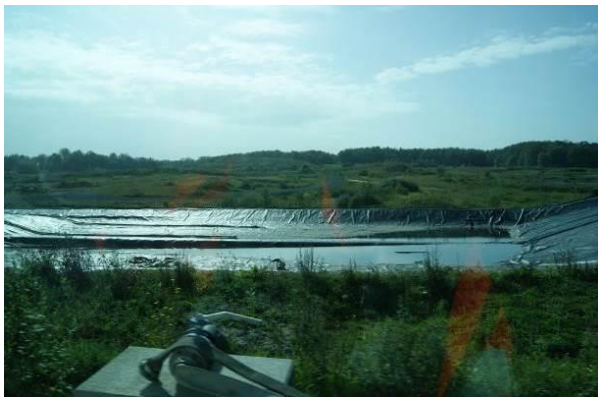
Foto 3: Sickerwasserbehandlungsbecken im östlichen Deponiegelände
