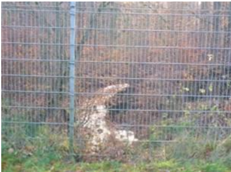
Abbildung 26: Einleitstelle gereinigtes Wasser
