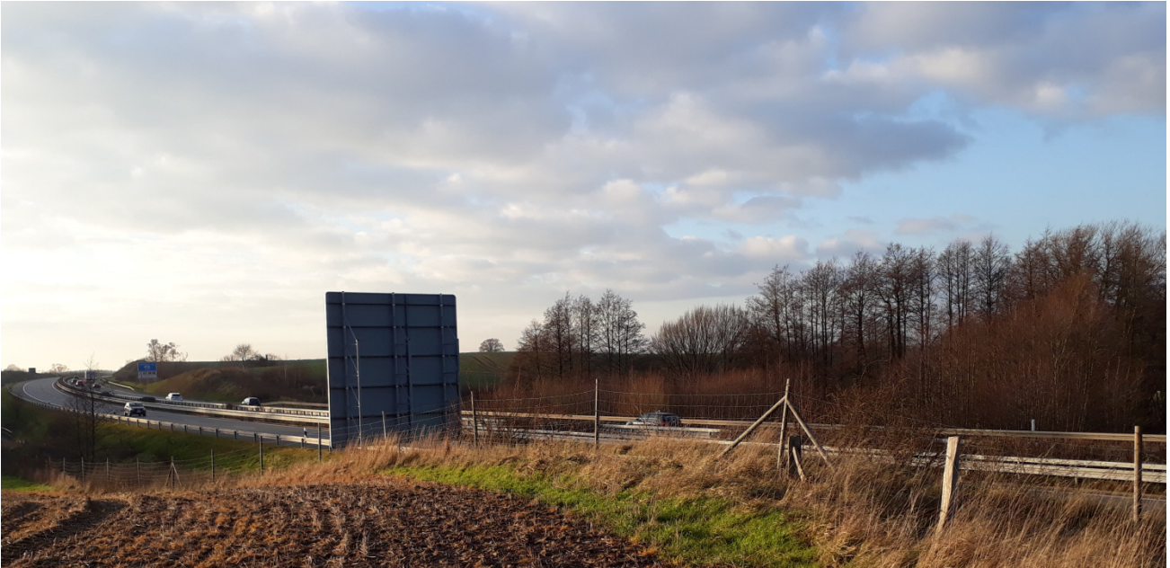
Bild S26: Blick in Richtung West über die A20 auf den östlichen Bereich von Teilfläche 2 (Quelle: Auftraggeber)
