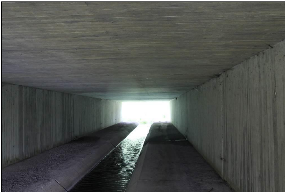
Abbildung 3: Durchlass des Baches (Wohlbäk) innerhalb des Plangeltungsbereiches
