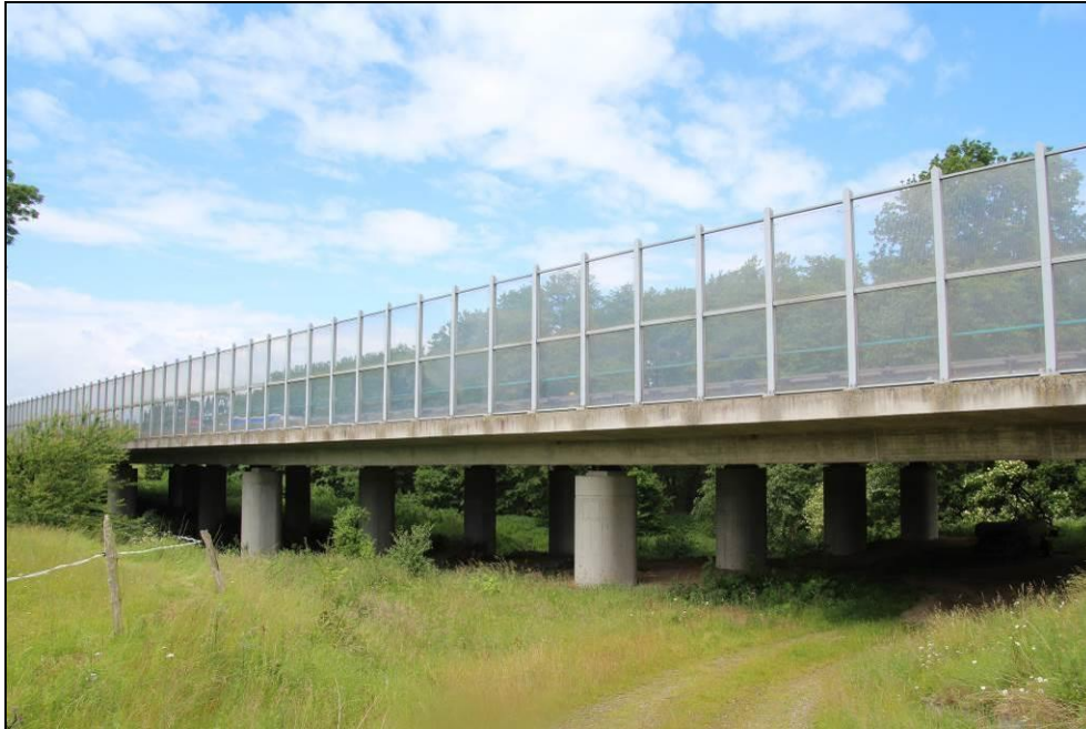
Abbildung 2: Talbrücke über die Maurine westlich des Plangeltungsbereiches
